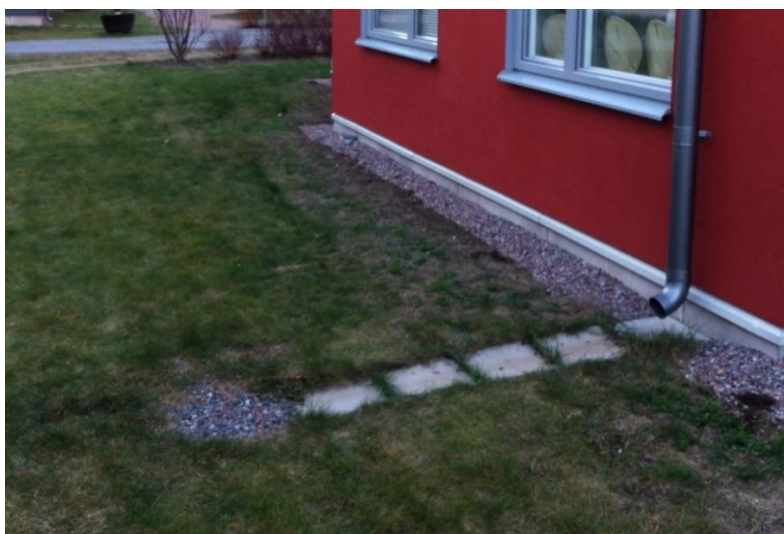
Figur 25. Exempel på avledning av takvatten via utkastare och rännalsten till stenkista i grönyta. Foto: WRS
