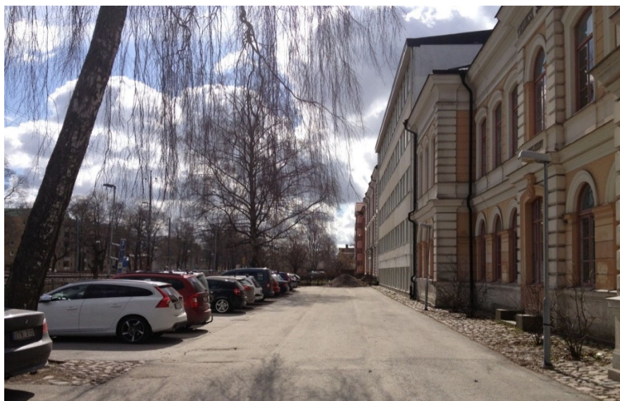
7 Foto taget från järnvägssidan visar kvarterets varierade fasader.
