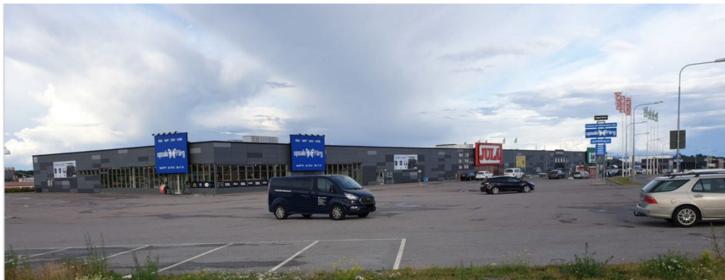
Figur 7, Bilden visar ett foto av bebyggelsen på fastigheten med tillhörande parkering. Bilden kommer från planbeskedet.
