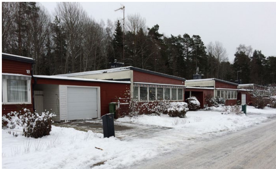
Bild 7 Kvarteret Skogschampinjonen sett från gatusidan. Det sammanhållna 1960-talsuttrycket är väl bevarat, även om en del carportar har byggts om till garage. Mellan garage/carport och bostadsdel syns passagen in till atriumgården.
