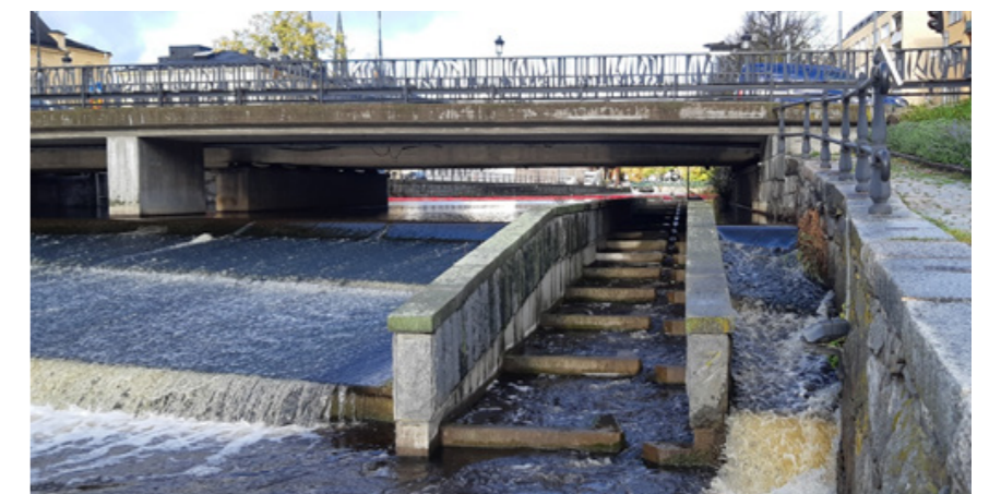
Figur 18. Asptrappan under Islandsfallet. Foto WSP Sverige AB.
