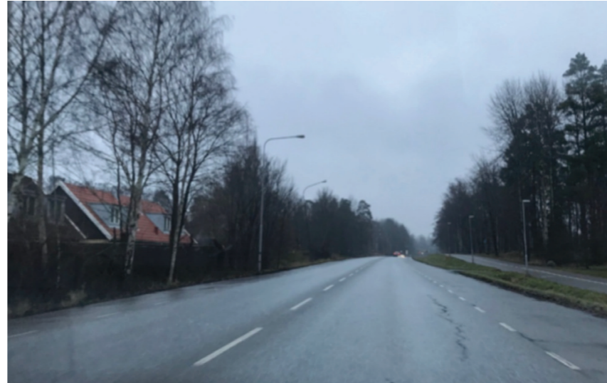
Figur 12. Vårdsättravägen sedd från söder. Den befintliga vägen kommer att breddas. Kollektivtrafikstråket är tänkt att placeras i mitten av gatuutrymmet. Visst intrång kommer att ske på några befintliga småhusfastigheter. Ett antal befintliga träd kommer tas bort, men biotopskyddade träd ersätts av nya.
