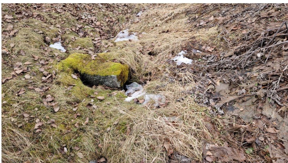
Figur 7. Krossmaterial och håligheter i dikesbotten.
