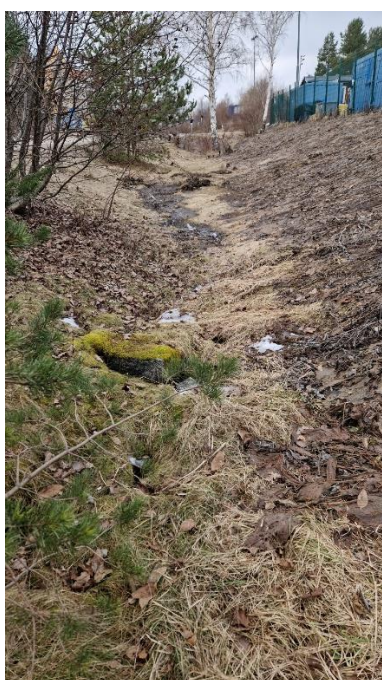
Figur 10. Krossmaterial, håligheter och vegetation i diket, foto från mars månad 2024.
