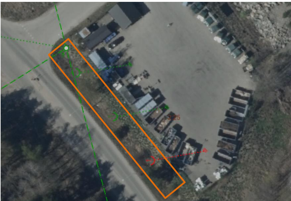
Figur 9. Ortofoto över återvinningscentralen, ledningsnät för dagvatten (grönt), i rött redovisas ungefärligt läge för en dagvattenbrunn och dess utlopp. Orange rektangel markerar diket som asfaltsytor avvattnas till.
