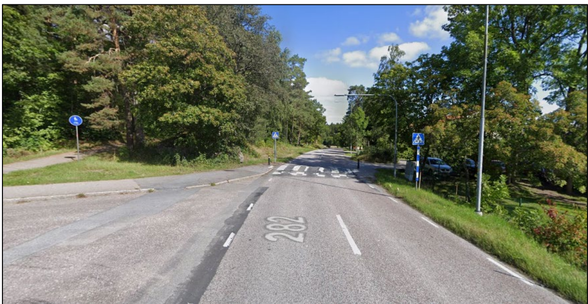
Bild 16. Almungvägen i höjd med korsningen för befintlig bussvändlinga, vy mot nordöst (skärmlapp från Google streetview)
