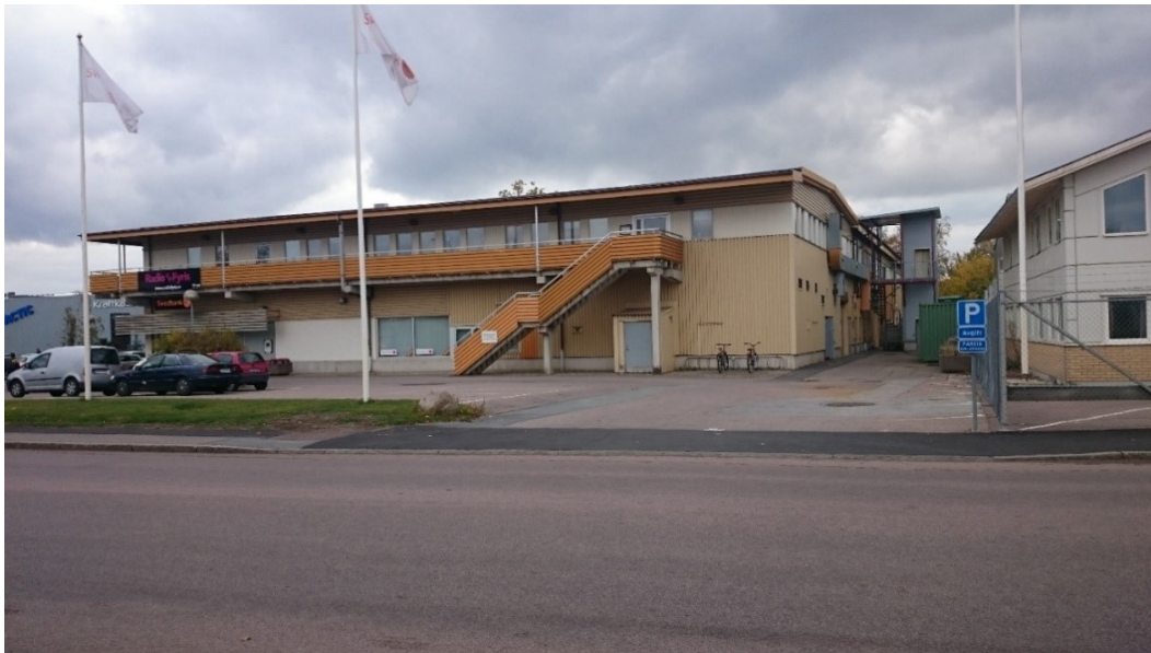
Den befintliga byggnaden sett från Björkgatan.
