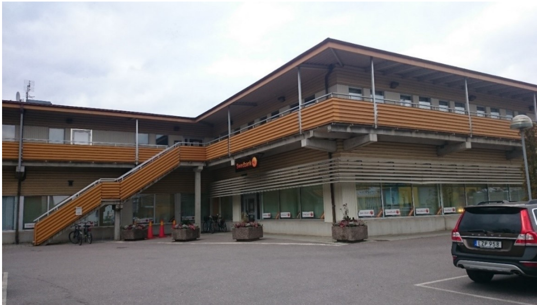
Den befintliga byggnaden inom planområdet sedd från parkeringen.
