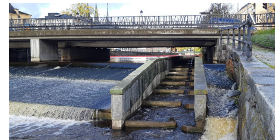
Figur 18. Asptrappan under Islandsfallet. Foto WSP Sverige AB.
