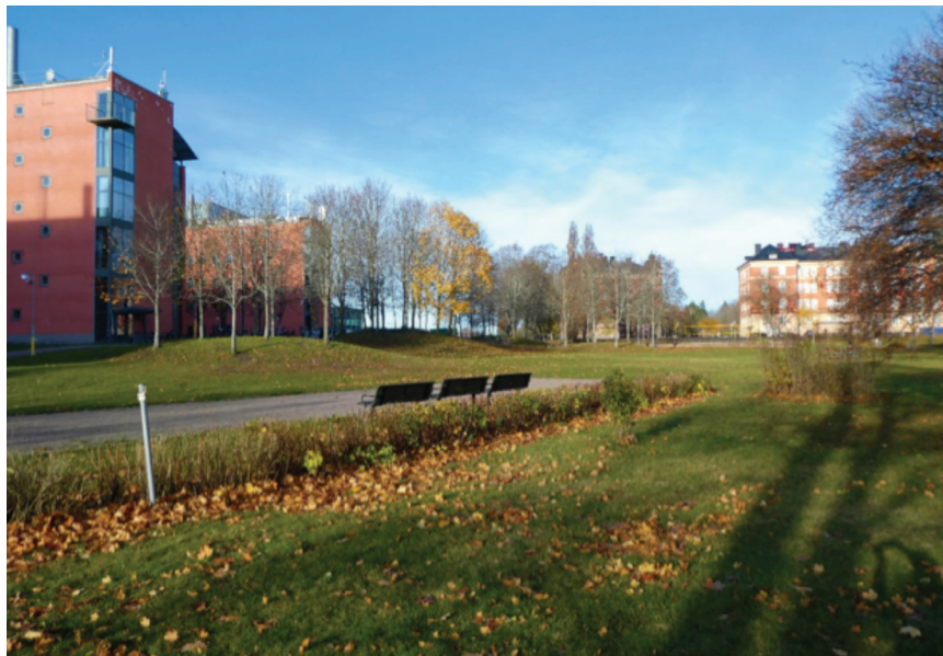
Figur 27. Området mellan Ångströmlaboratoriet och kasernbyggnaderna, där spåret dras fram. Vy från söder. Foto: SBF
