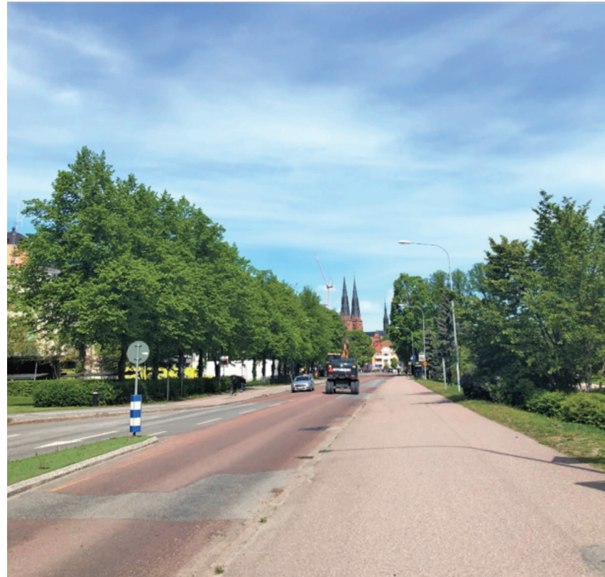
Figur 24. Sjukhusvägen med Stadsträdgården till höger i bild och domkyrkan i fonden. Vy från söder. Foto: White arkitekter.
