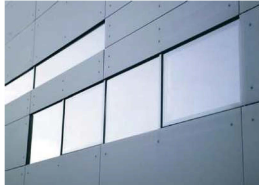
Exempel på fasad av glaselement
