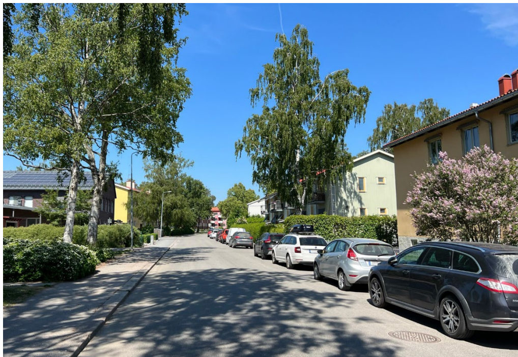
Bild 5. Gatuvy från juni 2023. Fotot är taget från Swedenborgsgatan med fastigheten Svartbäcken 32:5 i förgrunden. Byggnaden är ett gammalt barnrikehus som är ritat av Gunnar Leche.
