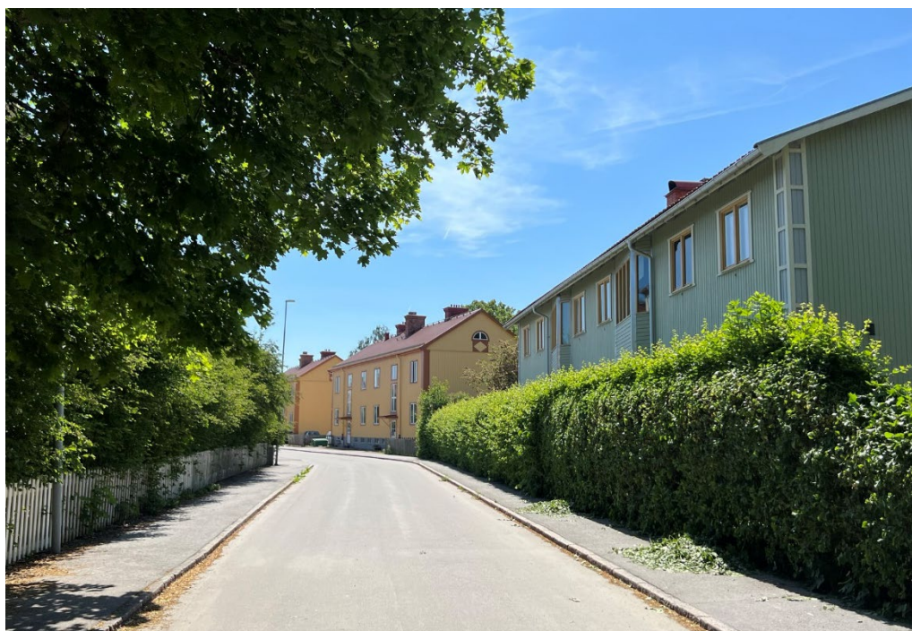
Bild 6. Gatuvy från juni 2023. Fotot är taget från Auroragatan med fastigheten Svartbäcken 32:8 i förgrunden. Huset i förgrunden renoverades i början av 2000-talet och de två husen längre bort på gatan är ritade av Gunnar Leche.
