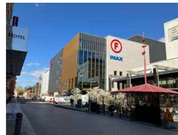
Ny bebyggelse i befintlig struktur längs Dragarbrunnsgatan.
