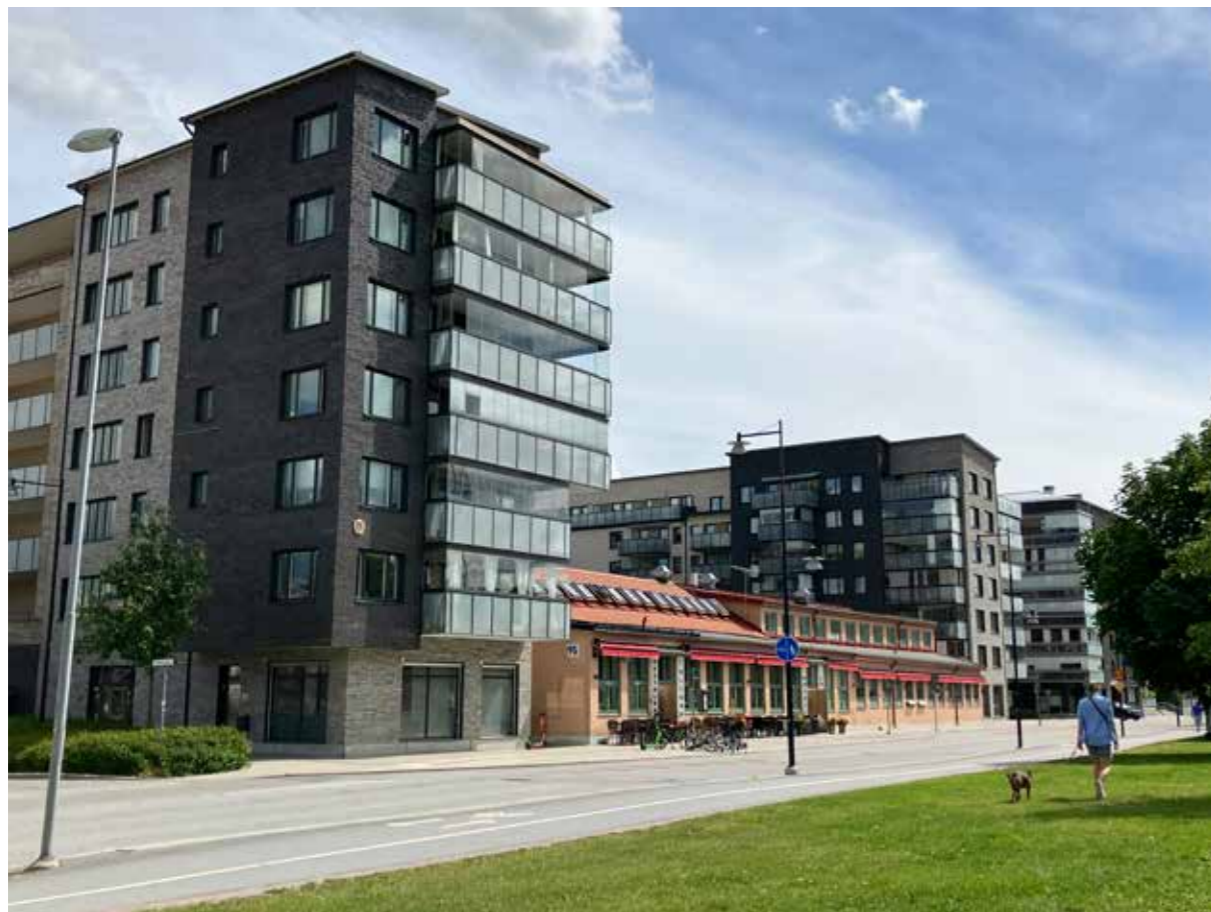
Exempel på nybyggnation och bevarandet av delar av gamla strukturen i Kungsängen.
