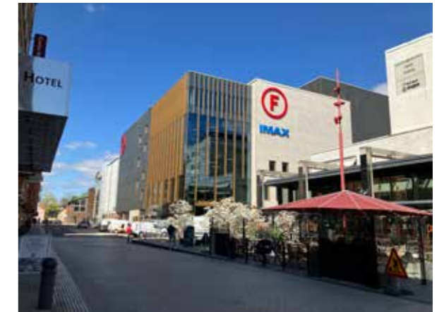
Ny bebyggelse i befintlig struktur längs Dragarbrunnsgatan.
