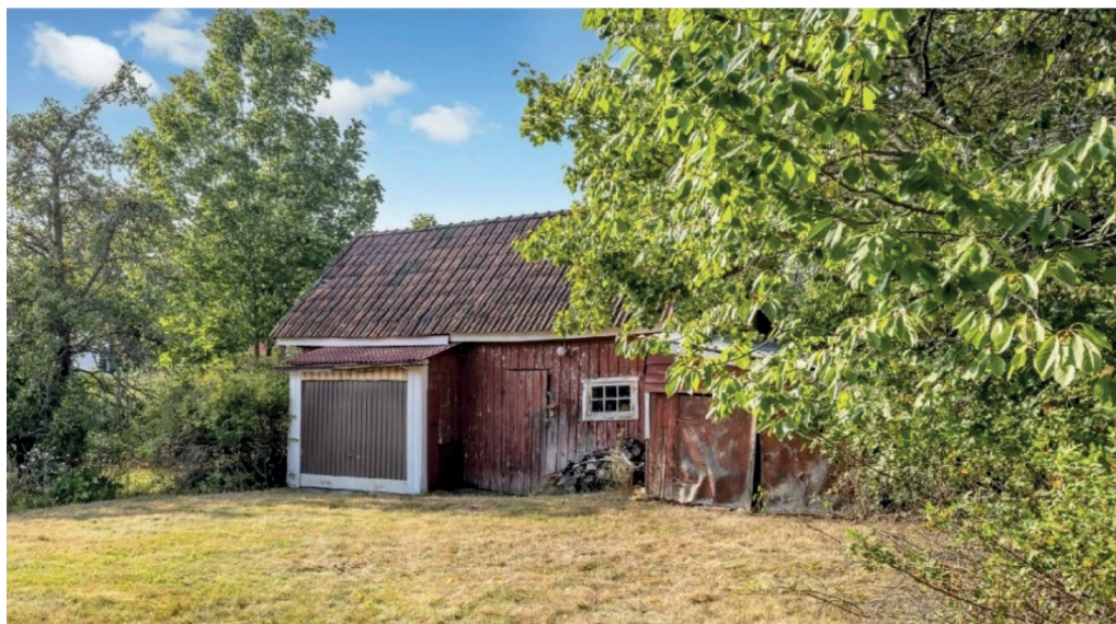
Figur 8 Foto på förråd och garage på fastigheten Norby 53:9. Källa: Widerlöv.
