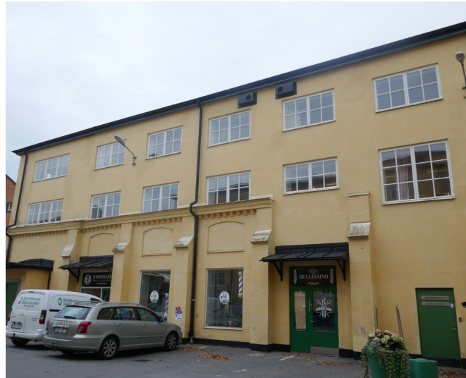
Framhusets västra fasad på innergården, bild tagen från öster. Dagens byggnad har kvar vissa detaljer från det gamla akademiska ridhuset så som strävpelare och listverk.
