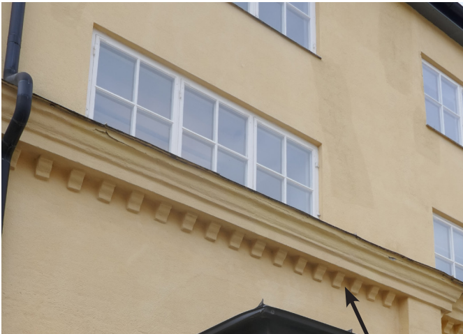
Takfoten på det gamla akademiska ridhuset
