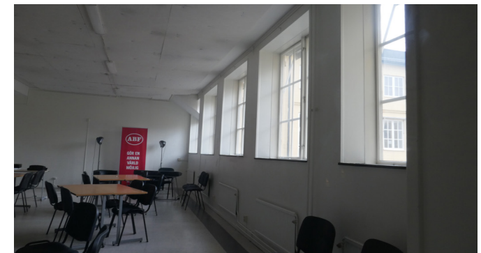
Interiört har byggnaden flera sekundära ytskikt med inga äldre spår bevarade varför det finns en tålighet för förändring.
