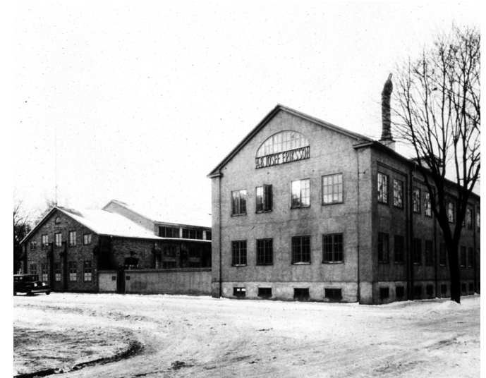
Framhuset mot S:t Persgatan och Storgatan. Bilden visar cykelfabriken efter branden och utbyggnaden på 1930-talet men innan fabriks huset till höger fick ytterligare en våning och nytt tak några år senare.
