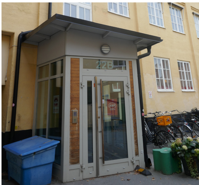
Nya portar från 2006. Bild tagen från fasadens östra sida mot innergården.
