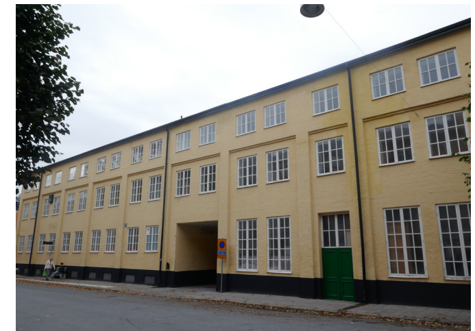
Bild tagen från Österplan och visar ventilationsrör på fasaden.
