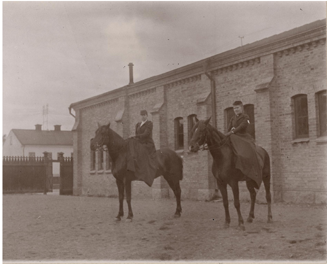
Ett historiskt foto på Torborg och Maria på varsin ridhäst utanför det akademiska ridhuset på S:t Persgatan 22, år 1893. Ryttarna står framför innergårdens västra fasad. Ridhuset hade tegelfasad med stickbågiga fönster och fasaddetaljer som strävpelare och profilerade listverk. Upplandsmuseet, okänd fotograf.
