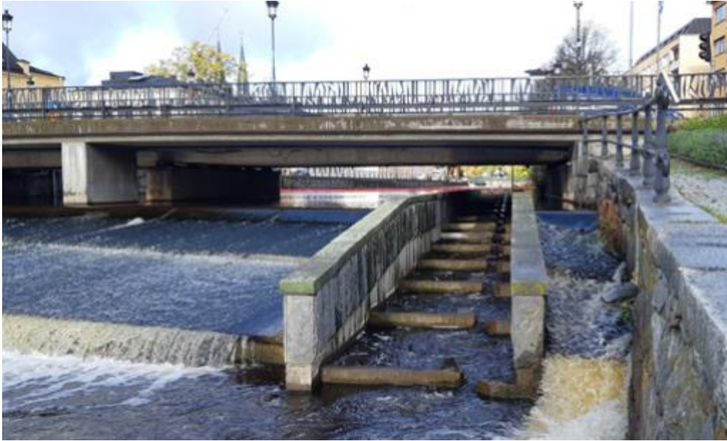
Figur 13. Asptrappan under Islandsfallet. Foto: WSP Sverige AB.
