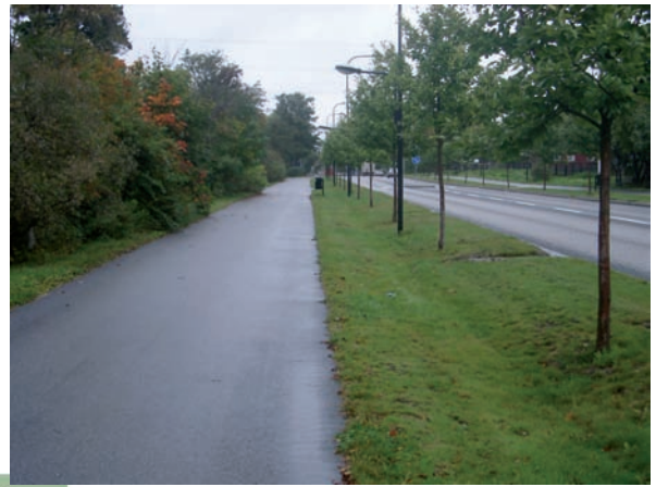
Dagvatten från gatumark kan ledas till planterade skålade diken där vatten kan renas/infiltreras.
