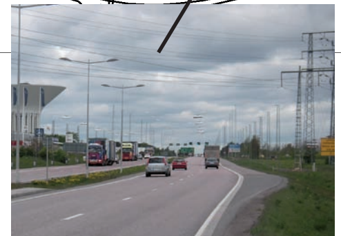
Tycho Hedens väg - omvandling från trafikled till en stadsgata som utgör en viktig del i stadens övergripande trafiknät och därmed ska hantera stora trafikmängder.
