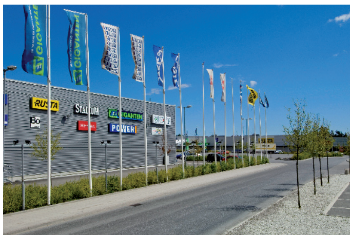
Exempel på fasad och miljö med samordnad skyltning och tydliga och prydligt utformade markytor.
