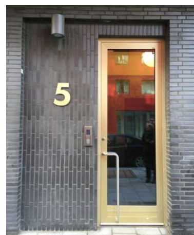
Recess i tegelfasad
