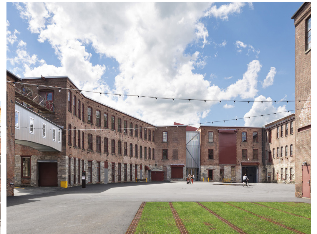
Referensbild: MASS moca building 6, innergård, ombyggnad
