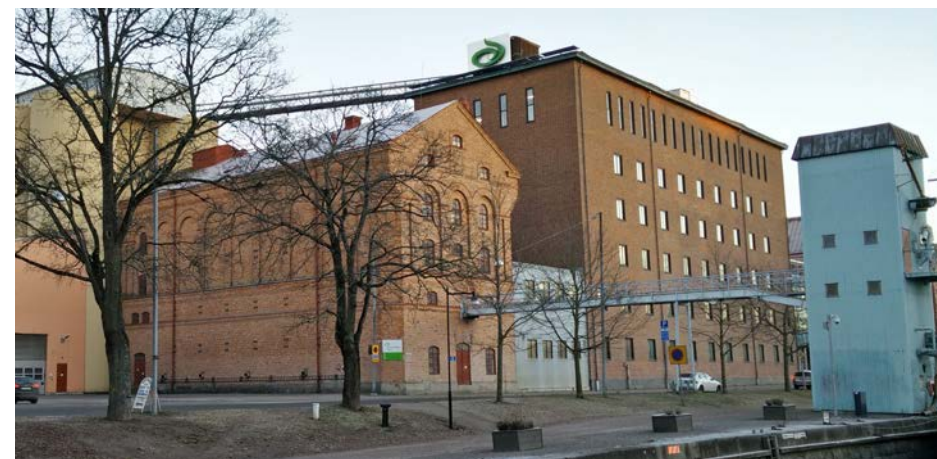
Foto: Norra entrén, Tegelsilon
