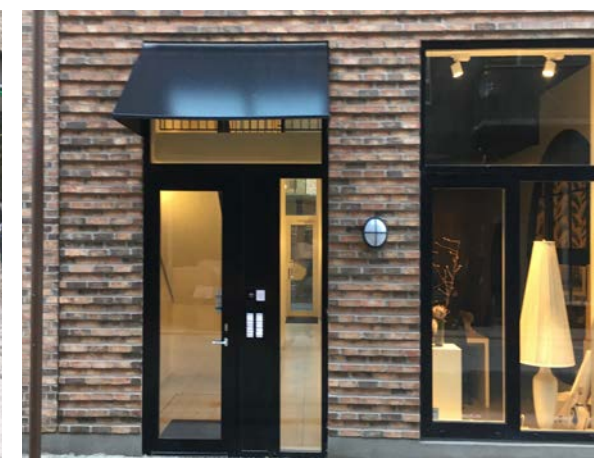
Svartmålad stål i entréparti och skärmtak
