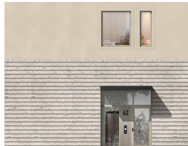
Betong, tegelsockelväning i en mörkare nyas än fasadmaterialet (B)
