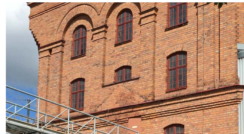
Foto: Västra gaveln, Tegelsilon
