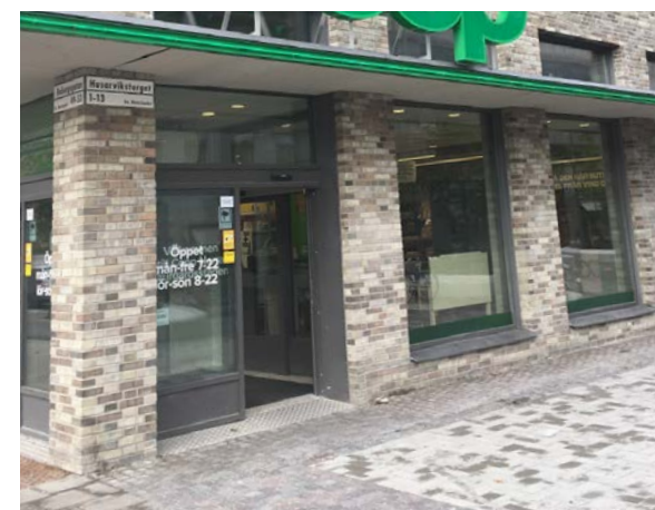
Entré till lokal målad i stål
