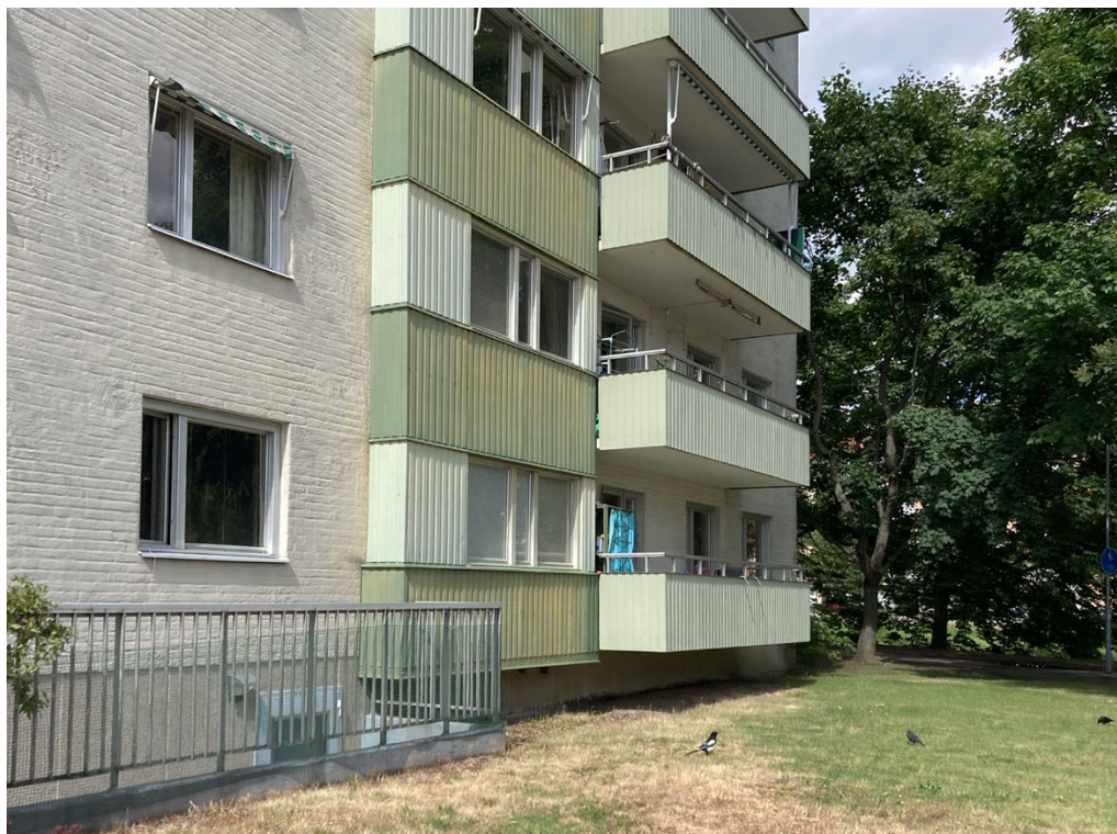
Bild 7. Foto som visar fasaden med plåtinklädda burspråk och balkonger som vetter mot Torsgatan.
