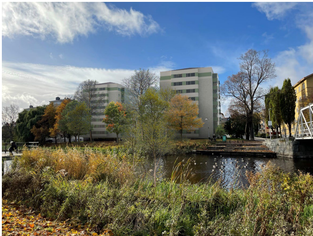
Bild 11. Illustrationer från fastighetsägarens förslag som visar punkthusen med det föreslagna tillägget av en extra bostadsvåning och en vind. Vyn är tagen från Fyrisåns östra sida. Illustrationer: PE Teknik & Arkitektur
