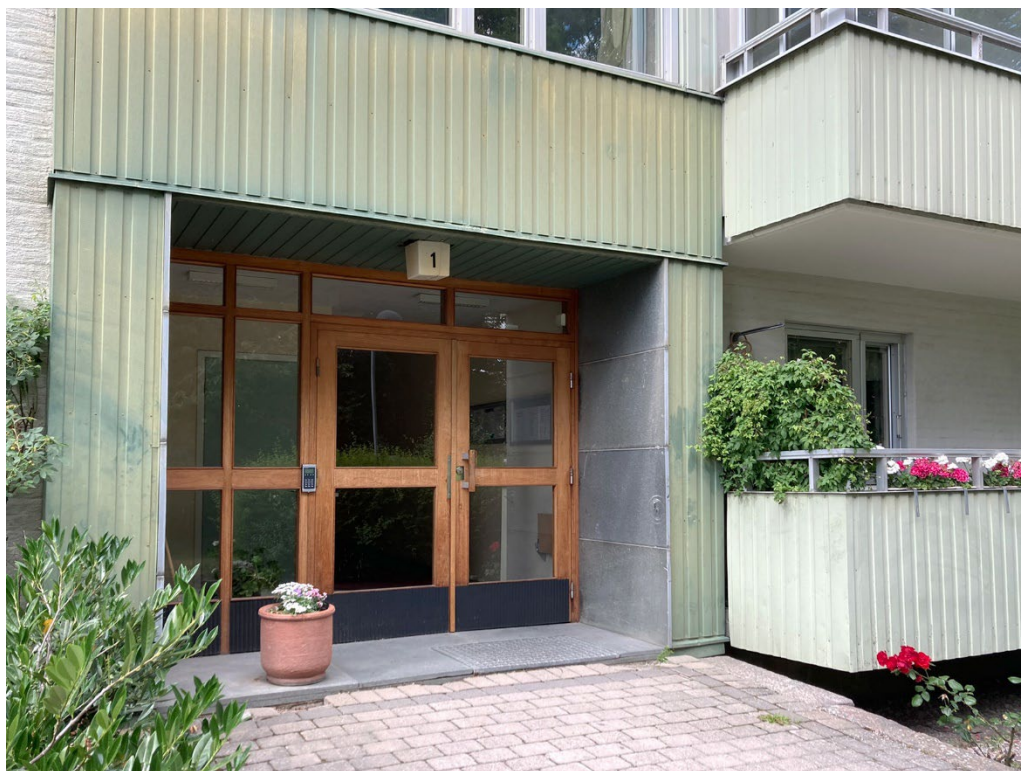
Bild 9. Foto som visar entrén till den norra byggnaden inom fastigheten.
