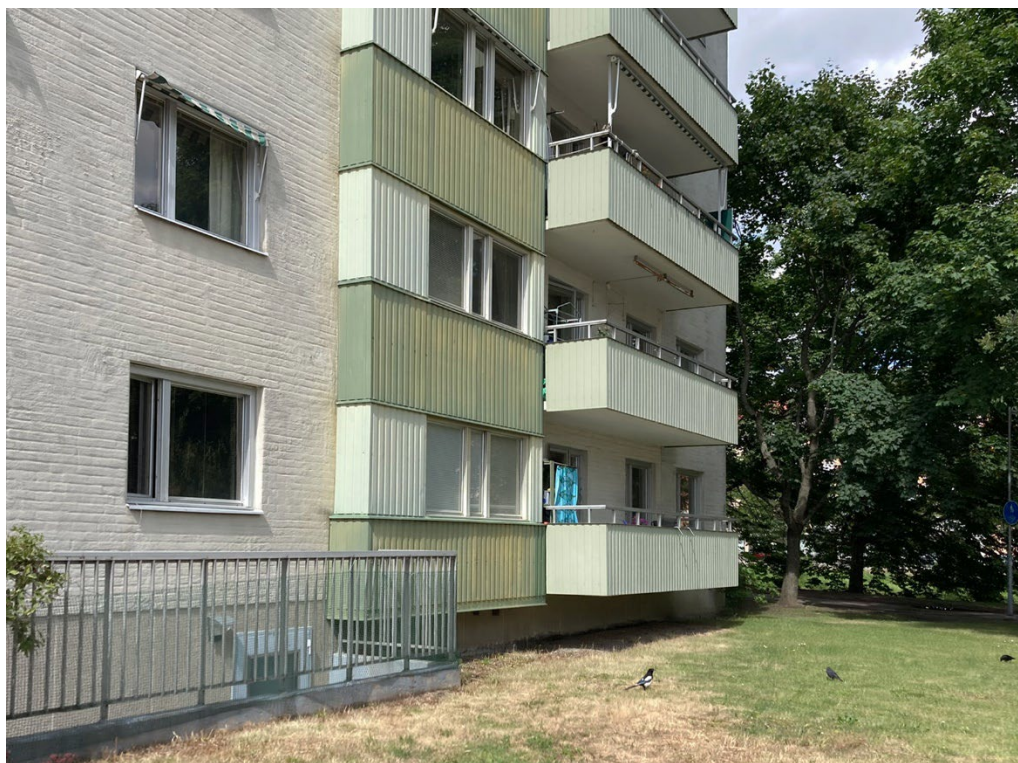
Bild 8. Foto som visar fasaden med plåtinklädda burspråk och balkonger som vetter mot Torsgatan.
