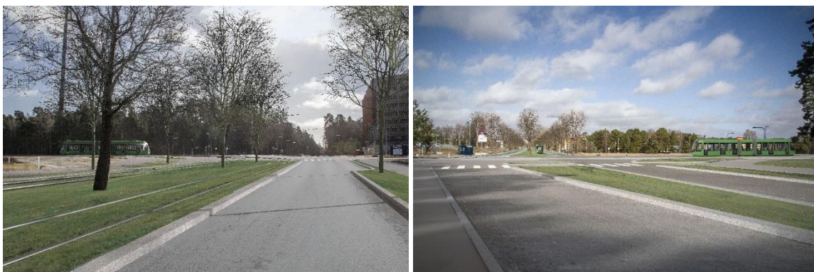
Korsningen Dag Hammarskjölds väg/Regementsvägen utan kontaktledningar.
