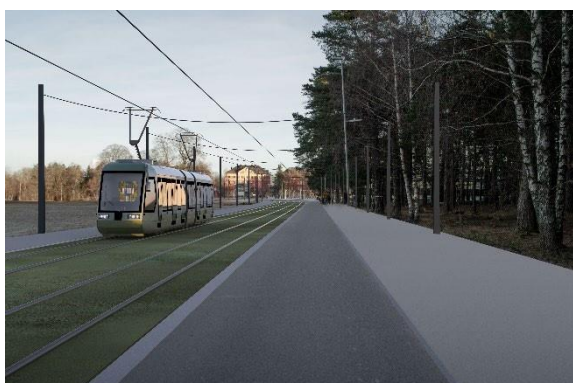
Regementsvägen med stolpar cc25 meter förbi Ångström
