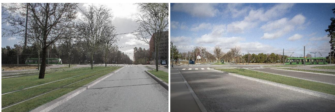
Korsningen Dag Hammarskjölds väg/Regementsvägen med kontaktledningar.
