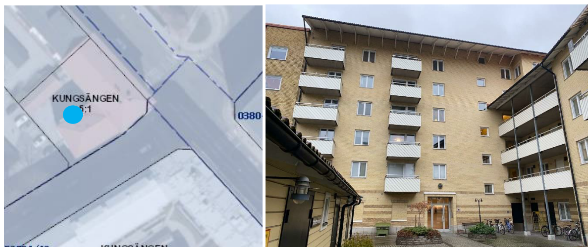
Figur 6 Vy över fastigheten
