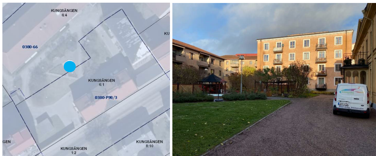
Figur 5 Vy över fastigheten
