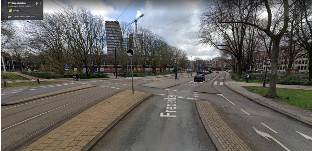
Figur 6-3 Exempel på en oreglerad nederländsk cykelpassage över spårväg, med tydliga väjningsregler, refug mellan bilväg och spår, svängkörfält för cyklister samt tydliga väjningsregler. Tydliga och separerade ytor mellan gång och cykel gör att gående inte använder cikelytor/passager eller vice versa. Bild: Google Streetview
