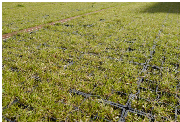
Figur 25. Armerat grässpår som kan trafikeras av räddningstjänst. Odense.
