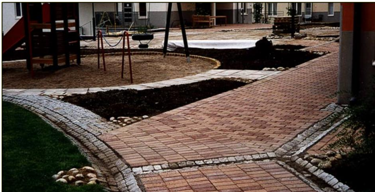
Figur 6-2. Exempel på avledning av takvatten via rännदार anlagda med gatsten (Källa: Stockholm Vatten B, n.d.).
