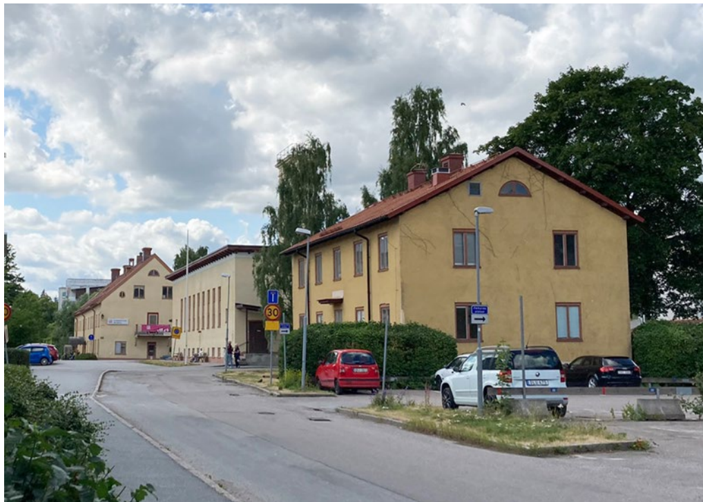
Figur 20: Foto som visar tre byggnader som ligger väster om planområdet och som omfattas av skyddsbestämmelser i gällande detaljplan, de två längst bort i bilden har dessutom rivningsförbud. Bilden är tagen juli 2023.
