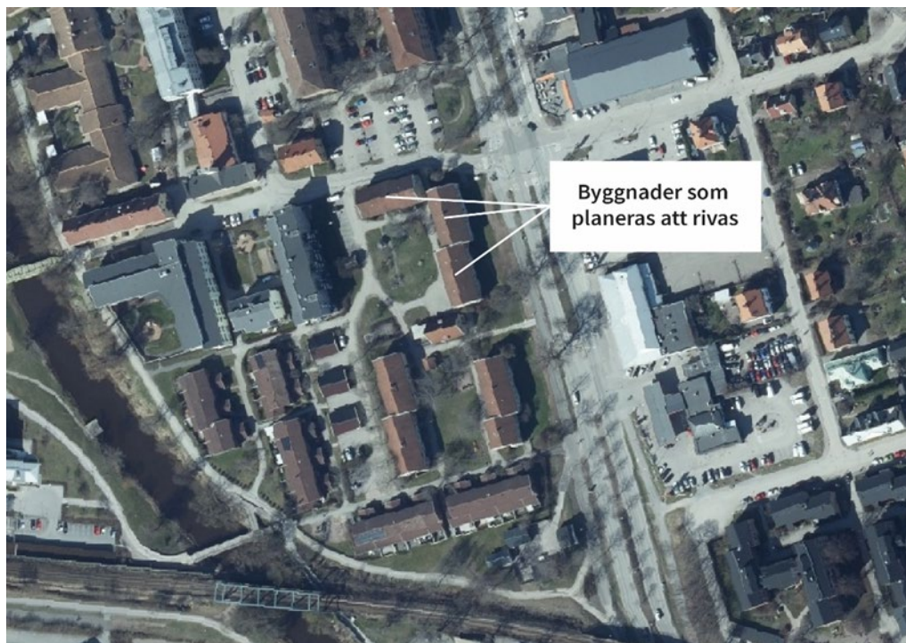
Figur 24: Ortofoto som visar vilka byggnader inom planområdet som fastighetsutvecklaren planerar att riva eller demontera.
