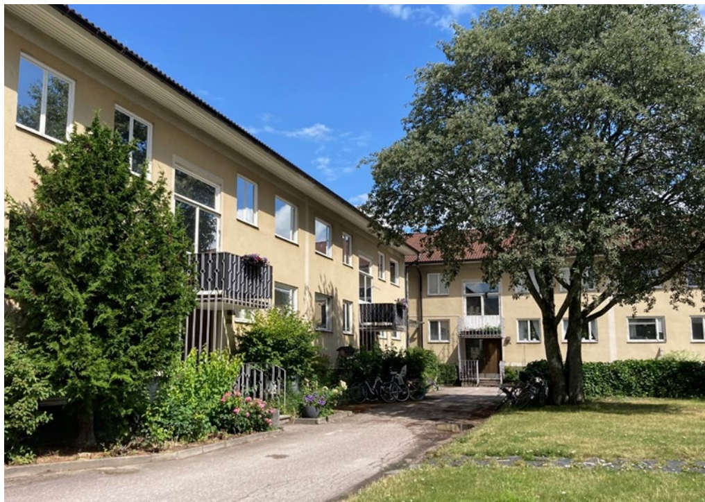
Figur 22: Foto som visar de två byggnader som fastighetsutvecklaren föreslår ska rivas eller demonteras. Byggnaderna ritades av tidigare stadsarkitekt Gösta Wikforss och uppfördes 1953. Bilden är tagen juli 2023.
