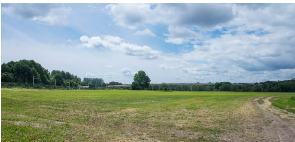
Figur 28. Bro för spårvägens delsträcka D med spårväg på bankar genom landskapet. Vy åt sydväst sett från Hemslöjdsvägen i Nântunas bykärna. Bankarna kommer med tiden att täckas med växtlighet.
