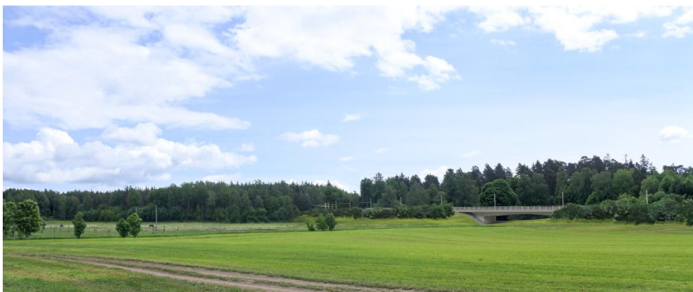
Figur 29. Spårvägsbro över Hemslöjdsvägen. Vy åt sydöst från jordbruksmarken öster om Fyrisån.
