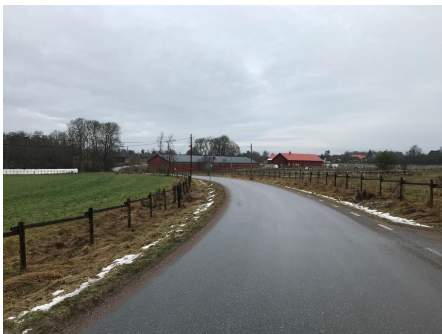
Figur 20. Pil 5. Vy mot Nântuna by från Hemslöjdsvägen.
