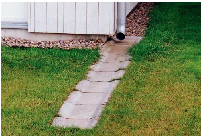
Figur 14. Utkastare och rännplattor för infiltration i grönyta.
