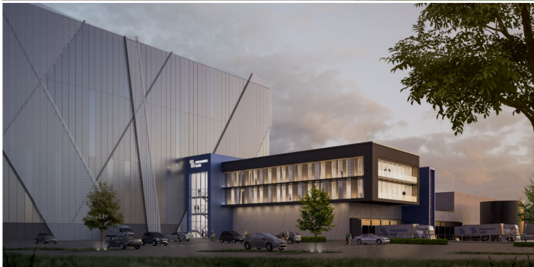
Vy sedd från Rapsgatan. Fotot längst upp visar Fresenius Kabis anläggning i nuläge och bilden längst ner visar den förslagna bebyggelsen. Illustration: JKAB arkitekter
