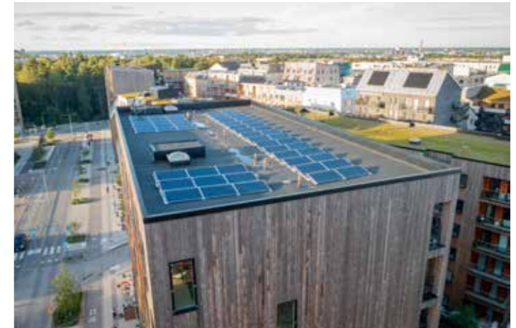
Exempel på solceller på taket.
