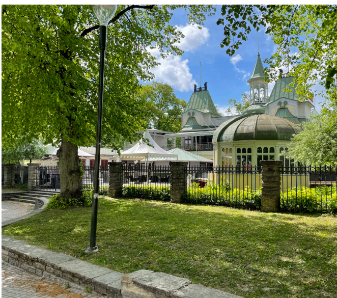
Flustret sett från Stadsparkens entré i nordost. Gjutjärnsstaket avgränsar området
