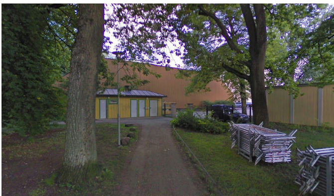
Svandamshallens stängda fasad samt teknikhus/förråd mot öster och mellanrummet mot Flustret.
