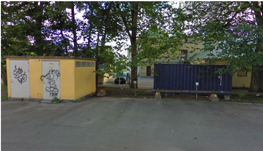
Teknikhus i form av nätstation samt container mellan Gymnastiken och Flustret.
