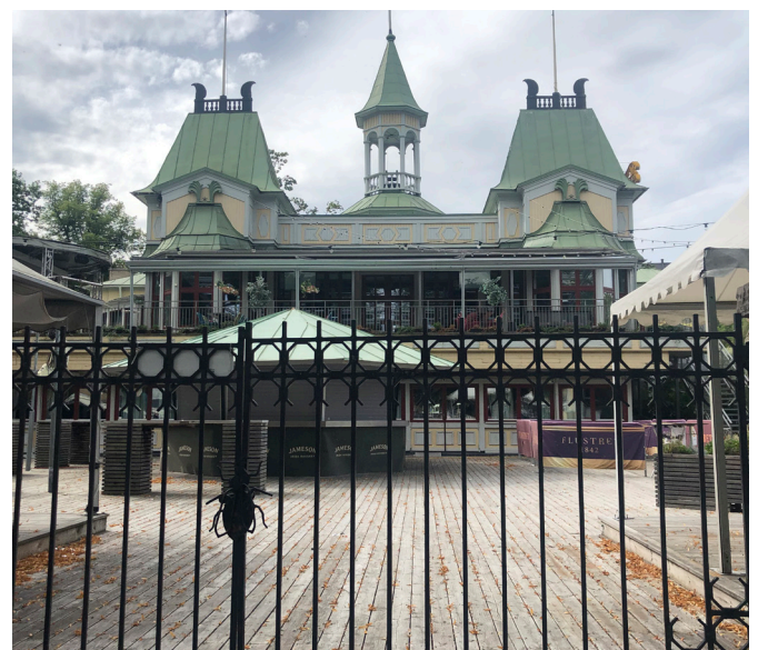
Gjutjärnsstaketet och avgränsningen möjliggör servering av alkoholhaltiga drycker.
