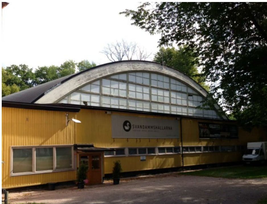
Bild 24 - Bollhusets framsida mot väster, Stockholms byggnadsantikvarier AB, 2013
