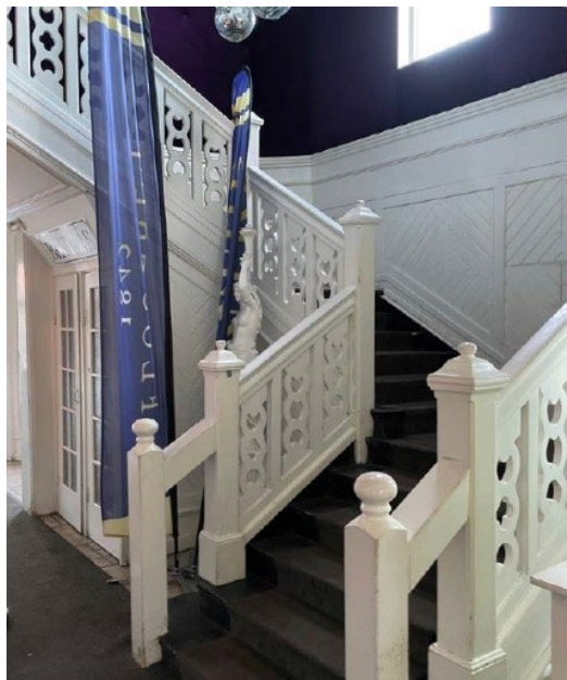
Bild 14 - Det norra trapphuset som tillkom på 1870-talet. På 1920-talets byggdes trappan om och har delvis bevarats.
