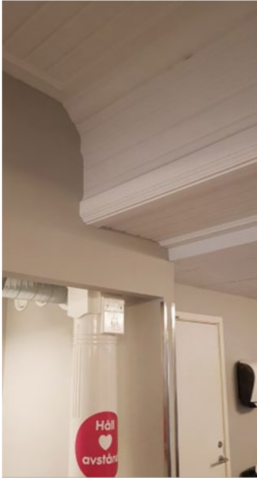
Bild 17 - Detalj av balkar och tak klädda i trä och gjutjärnspelare, Sweco
