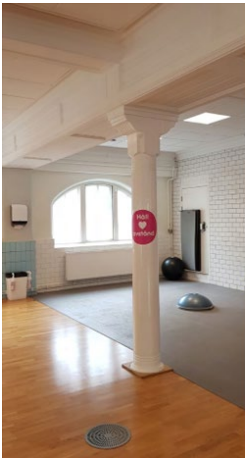
Bild 18 - Bilden visar gjutjärnspelare, trärak bågfönster och kakel i simbassängen, Sweco.
