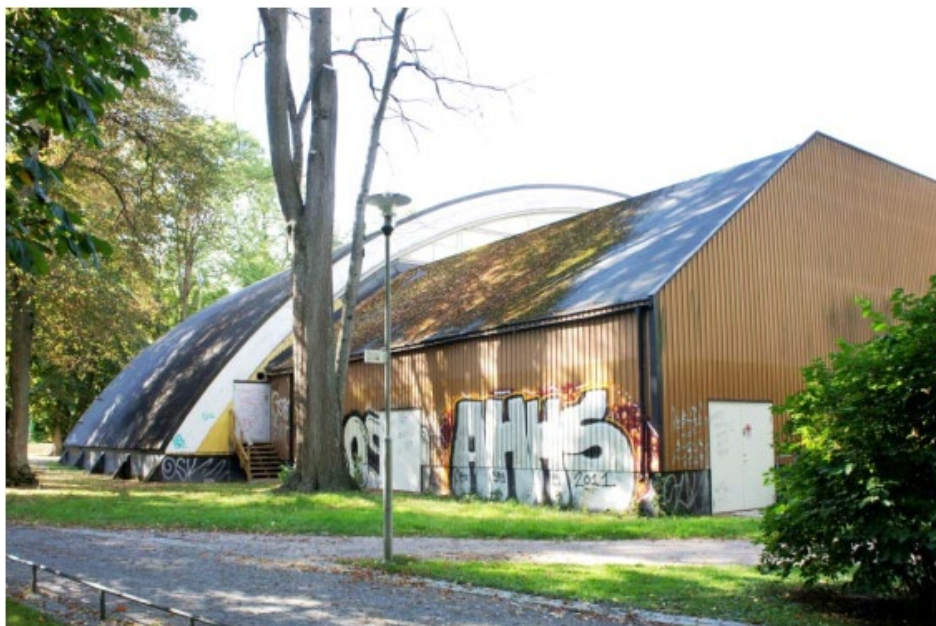
Bild 25 - Bollhusets baksida mot söder med den tillbyggda tennishallen från 70-talet, Wenanders Byrå, 2013.
