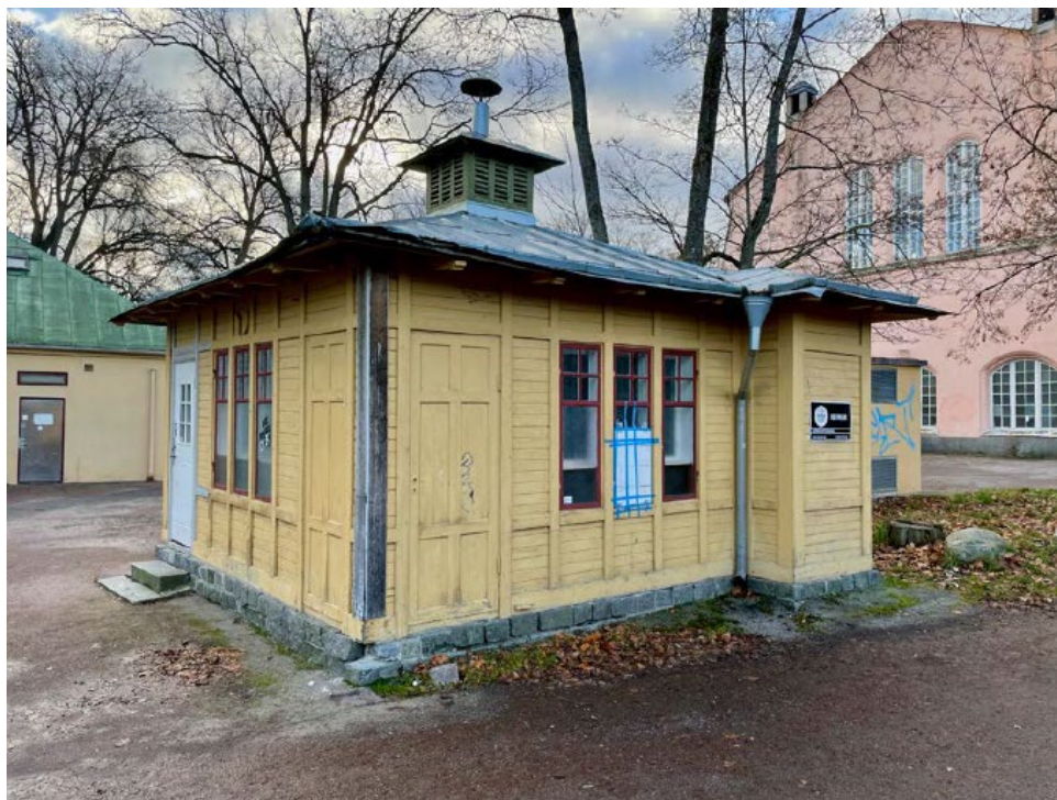
Bild 16 - Klosettbyggnaden med sin tidsenliga exteriör. Ventilationshuv kan kopplas till byggnadens tidigare funktion, Libeck antikvarie.
