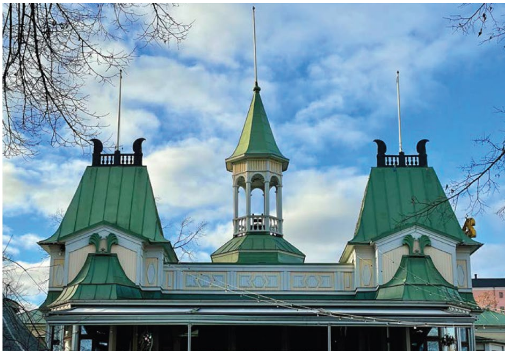
Bild 12 - Flustrets karaktäristiska taksiluett med hörntorn och mittorn. Dekor är både original och återskapad i form av bland annat listverk, balustrader, fyllningsmarkeringar, ljusramp och akroterier på tornhuvarna, Libeck antikvarie.
