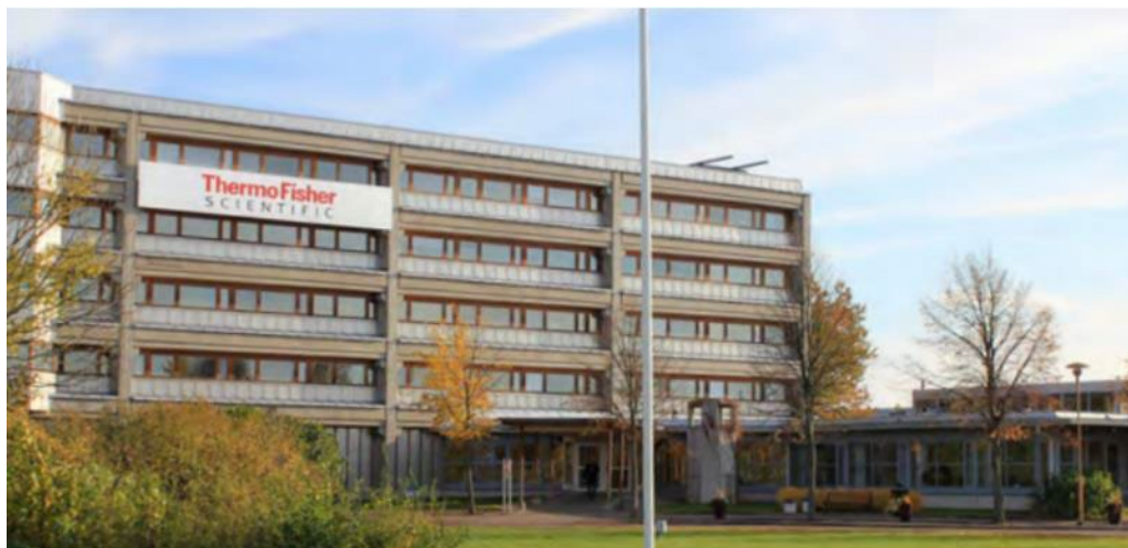
Bild 22 Huvudkontoret (hus 35) och den lägre matsalsbyggnaden (hus 31). Foto: Kulturmiljöutredning, WSP.
