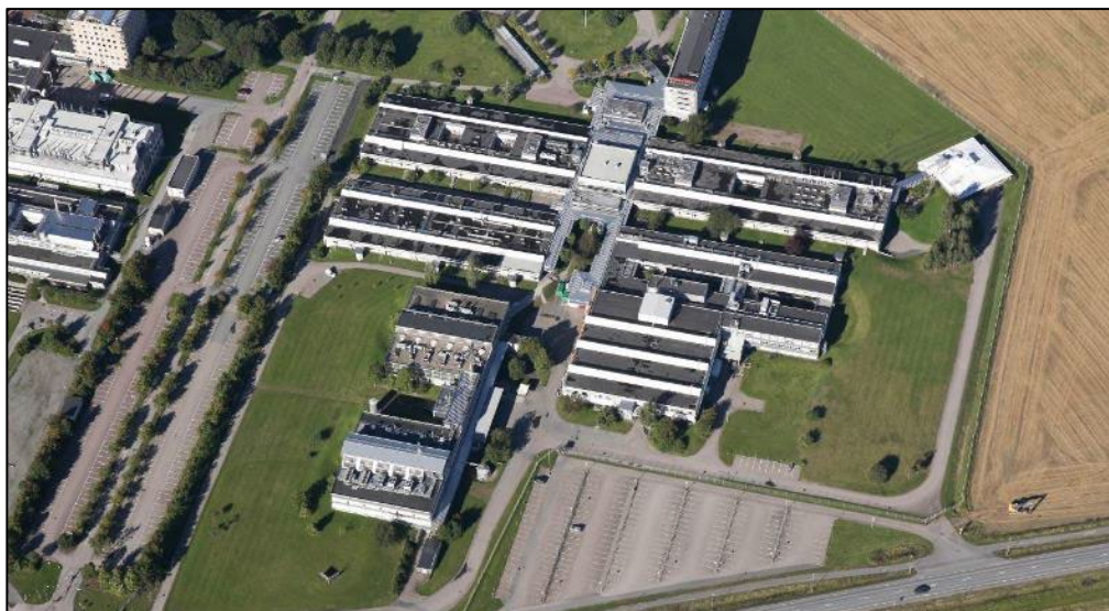
Bild 7 Flygbild orienterad mot norr. I bildens överkant syns Thermo Fishers huvudkontor (hus 35). I framkant mot Almungevägen syns de lägre laboratoriebyggnaderna. Bildkälla: Corem
