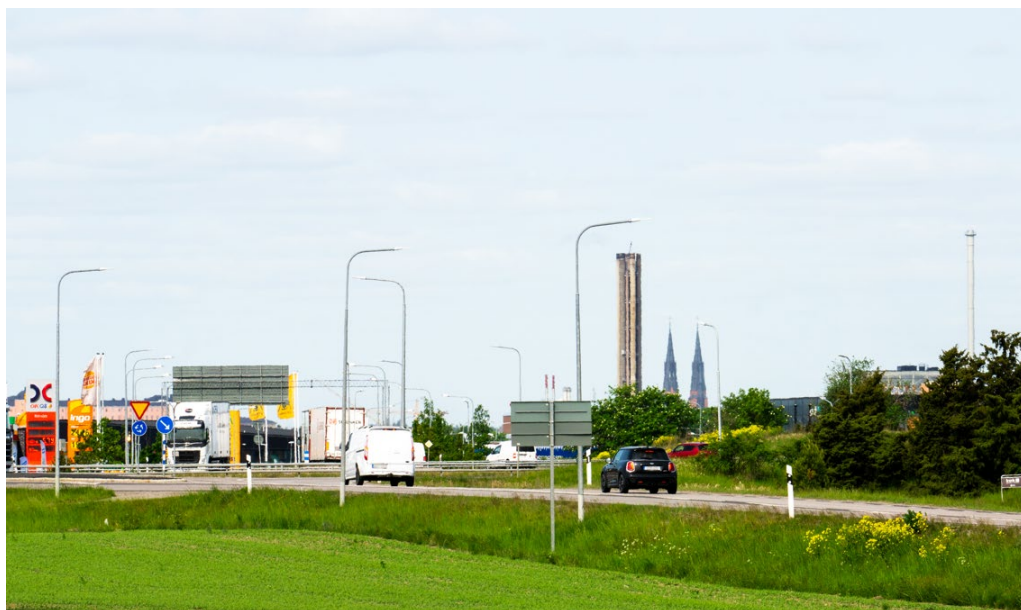
Bild 14 Vypunkt från väg som ansluter till väg 282.
