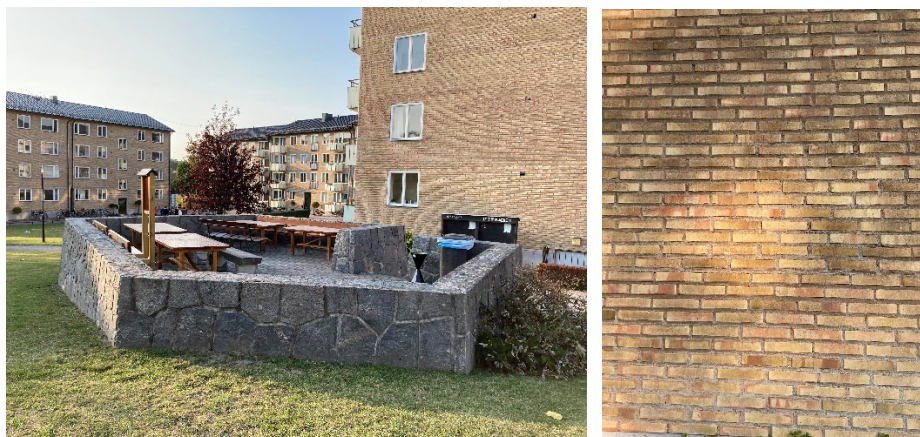
Bild 15 Foton på den bastionsliknande uteplatsen och närbild på tegelfasaden.
