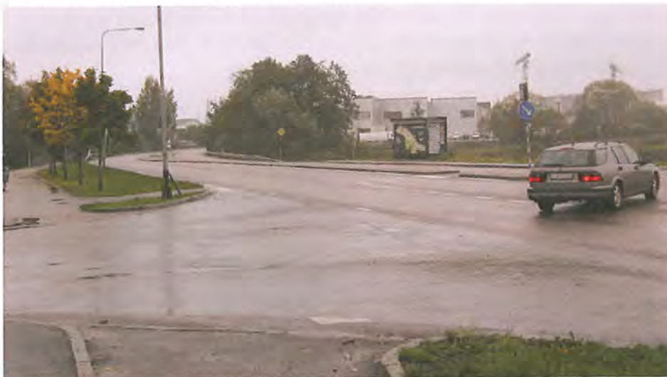
Figur 6. I korsningen med Skebogatan, från Uppsala vidare västerut (mot höger). Refug och svängfält på Börjegatan.
