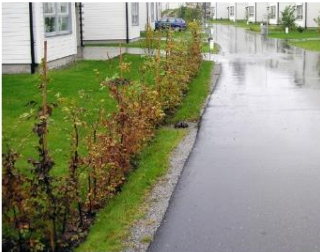
Figur 5-3. Till vänster om vägen finns ett underliggande makadamdike som har en häck planterad ovanpå. I det översta lagret blandas mindre fraktioner makadam med jord och i botten placeras grövre makadamfraktioner.
