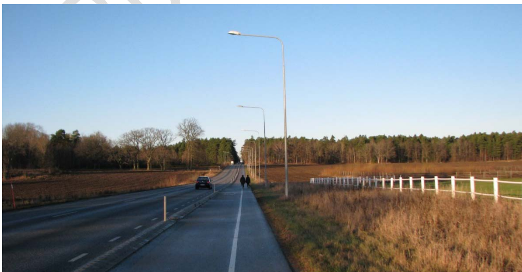
Vy mot Ulleråker från Dag Hammarskjölds väg vid Ultuna.
