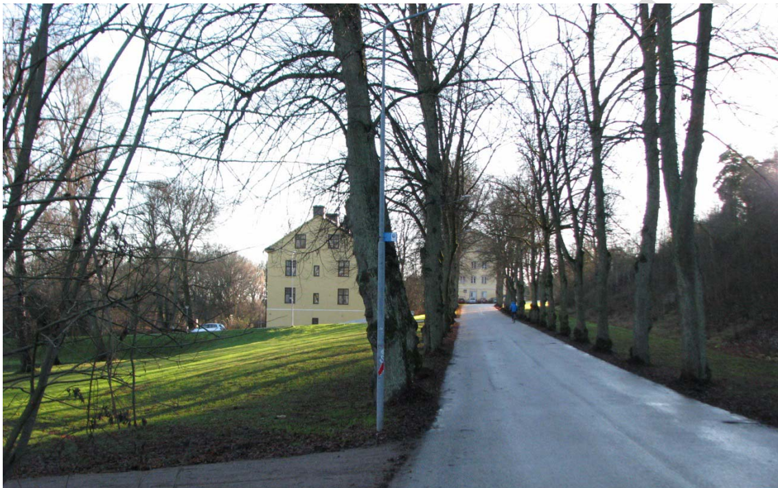
Kronobränneriets två kvarvarande byggnader vid Ulleråkersvägen.
