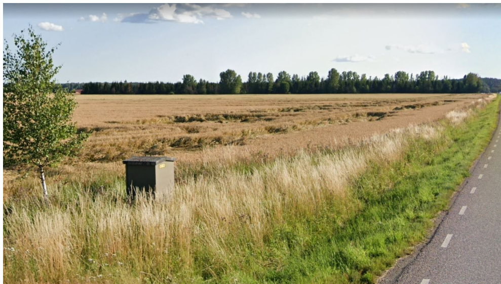
Figur 29 En av elbyggnaderna längs väg 630 som kan behöva flyttas i anläggningsskedet. Källa: Google maps.
