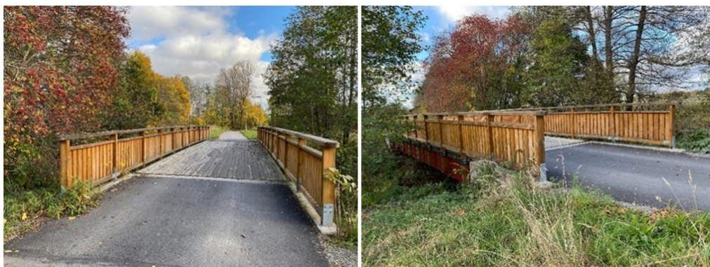
Figur 13 Exempel på en låg gång-och cykelbro i trä utan stödben. Bron är en del av gång- och cykelvägen mellan Tunabackar och Librobäck och ligger intill Fyrisån.
