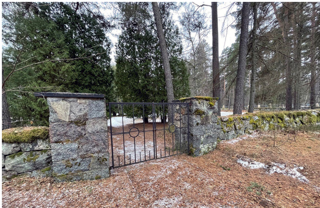
Bild 39 Ulleråkers kyrkogård. Entrén mot Emmy Rappes väg. Kallmurad granitmur och smidesgrind.
