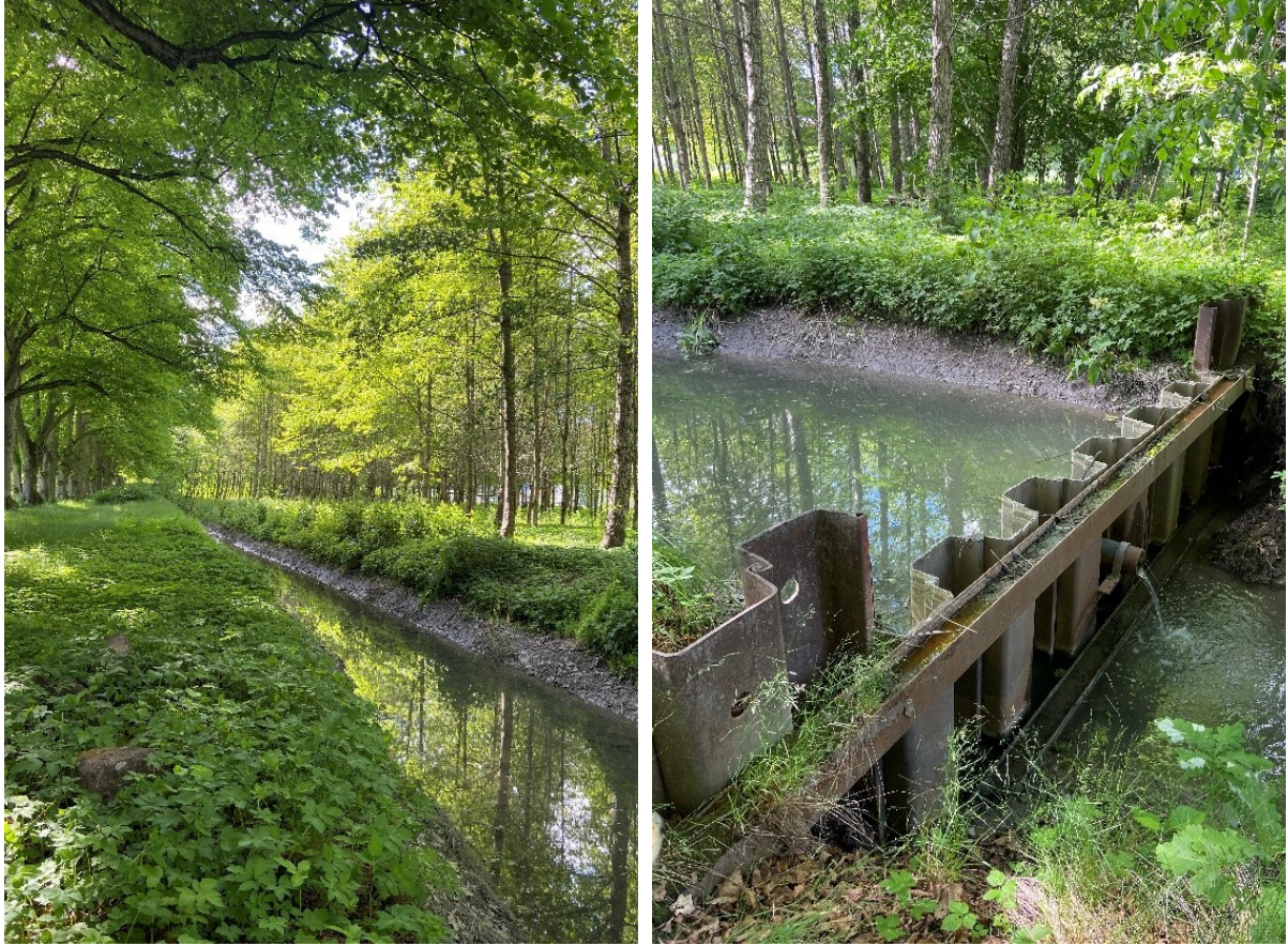
Figur 5. Platsbesök 2022-06-11. Diket är vattenfyllt och avtappas via utloppsledning D200 i dämnet.
