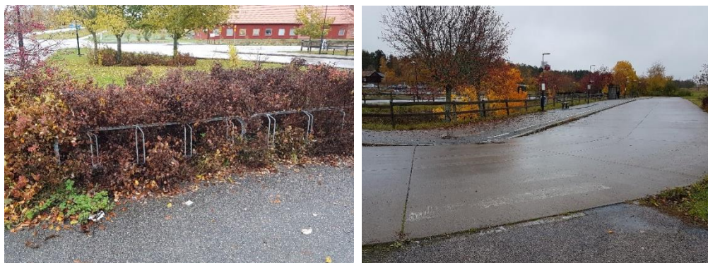
Figur 13. Cykelställ och övergångsställe som är nästintill utsuddat vid Almunge skola. Foto: WSP 2019.
