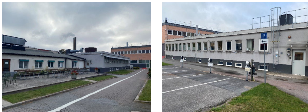
Figur 11 Bilderna visar den södra byggnaden, uppförd 1967.
