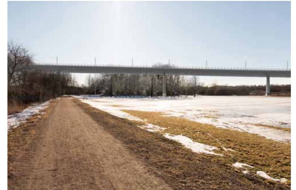
Fotomontage med uppvuxna trädplaneringar, ungefär 15 år fram i tiden från färdigställandet av utbyggnaden.
