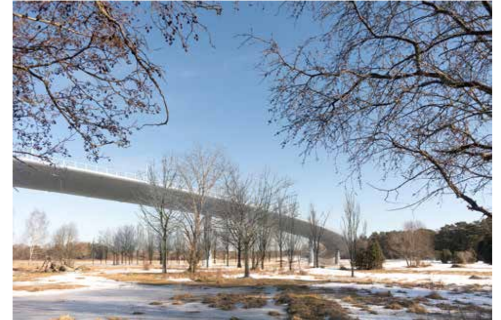
Fotomontage med uppvuxna trädplaneringar, ungefär 15 år fram i tiden från färdigställandet av utbyggnaden.
