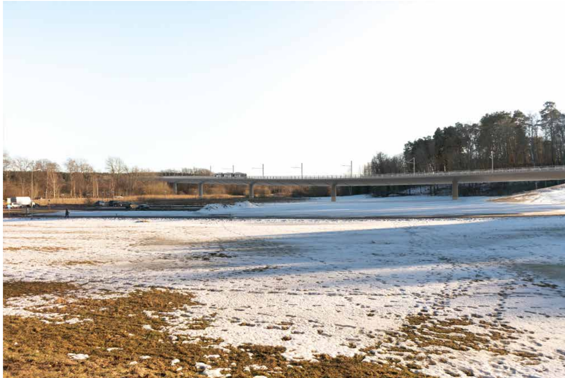
Utblick söderut från Duhrevägen i höjd med campusrestaurangen "Syltan". Bron lutar nedåt för att därefter vika uppåt från höger till vänster i bild. Från den här vypunkten när alternativen närmast identiska.
