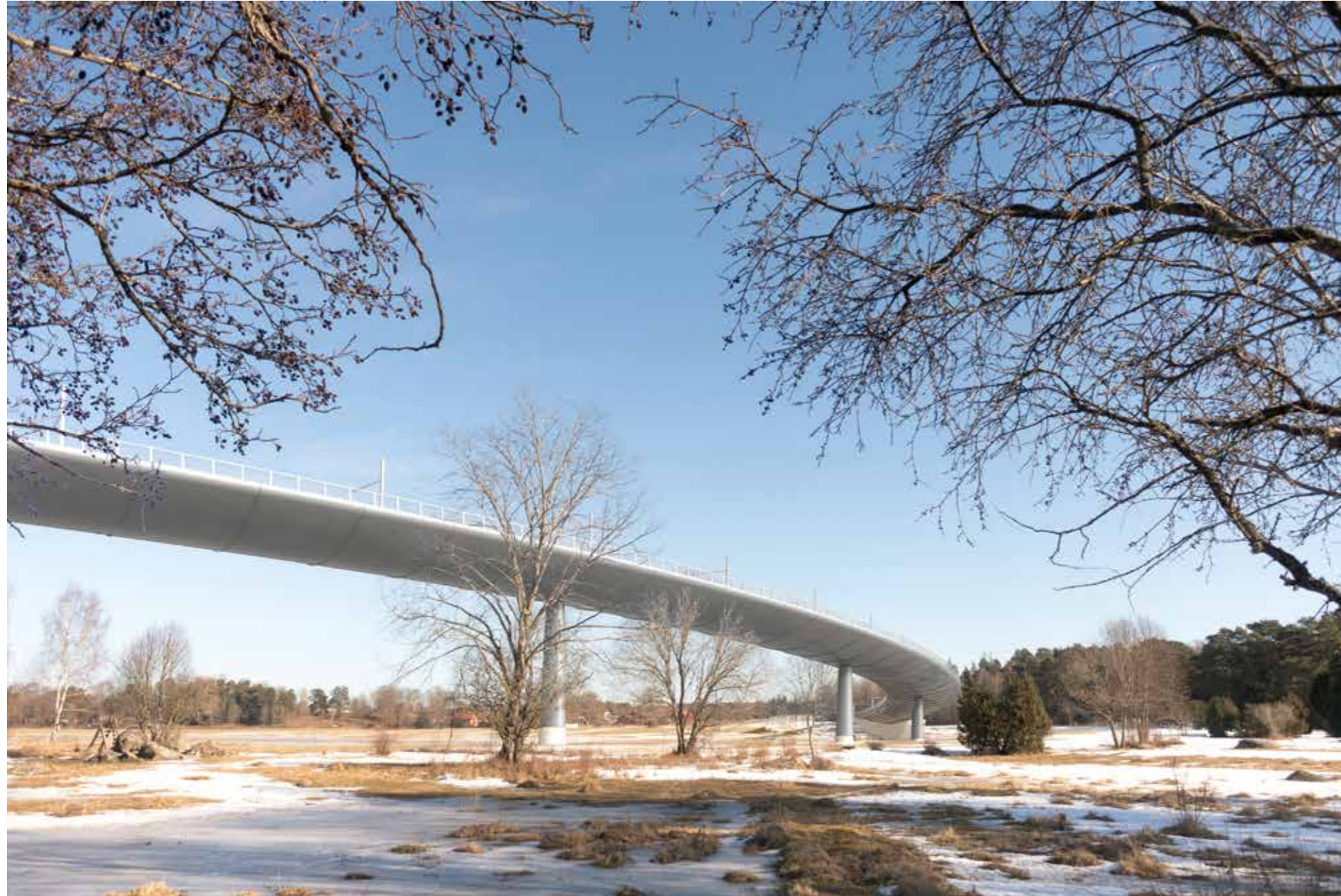
Utblick norrut, nära Fyrisåns östra strand, strax söder om bron. Gränsen mellan jordbruksmark och betesmark går precis framför bron i denna vyn. Från den här vypunkten har bron en tydligt brantare lutning mot Fyrisån än alternativ F.
