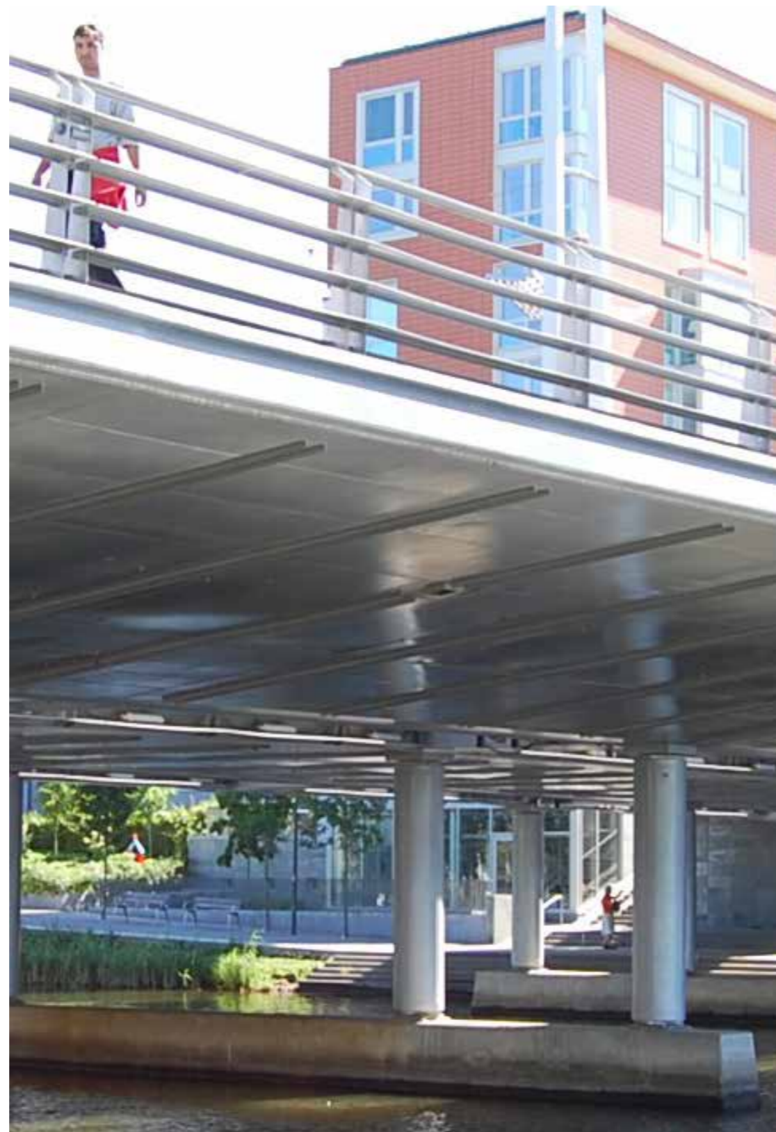
Blank stål med "stålfalsar", referens Allébron, Hammarby Sjöstad, & Rundquist
