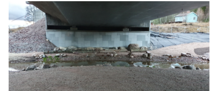
Stockar och stenar läggs ut på marken under bron
