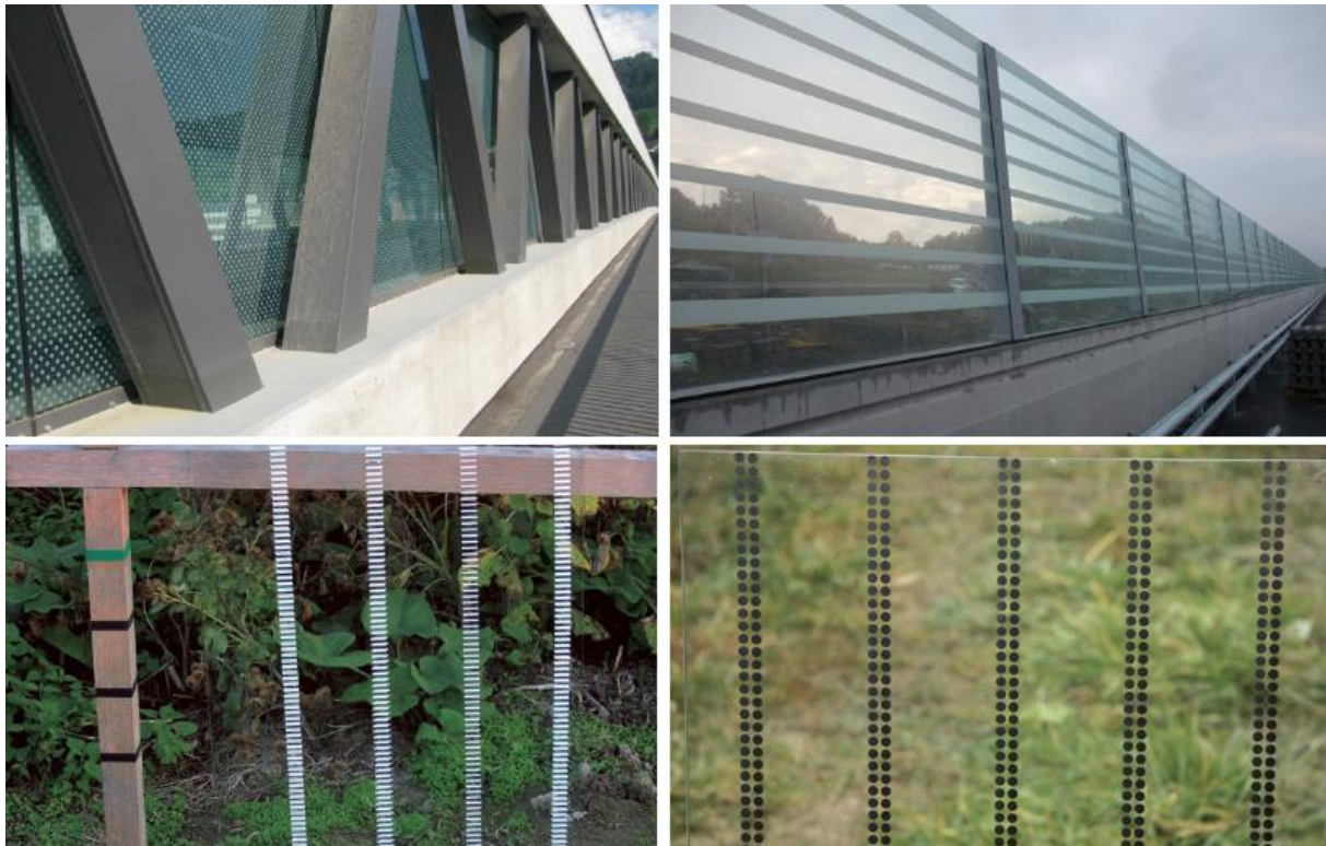
Figur 14 Exempel på markeringar på genomskinliga bullerskärmar som minskar påflygningsrisken för fåglar.
