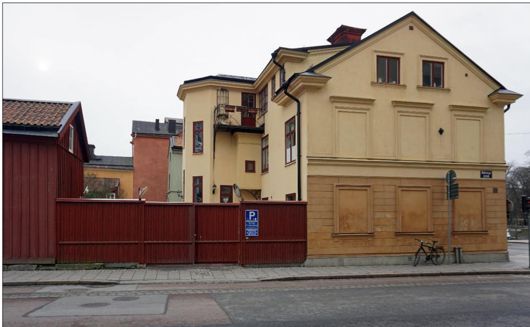
På den sydöstra sidan av gården finns i kvarteret Gudrun välbevarad 1800-talsbebyggelse, där speciellt hörnfastigheten mot Östra Ågatan utmärker sig med sitt gamla uthus mot gården, uppfört efter byggnadssyn 1840. Huvudbyggnaden uppfördes 1865, fick putsfasad 1885 och inreddes med vind 1920.
