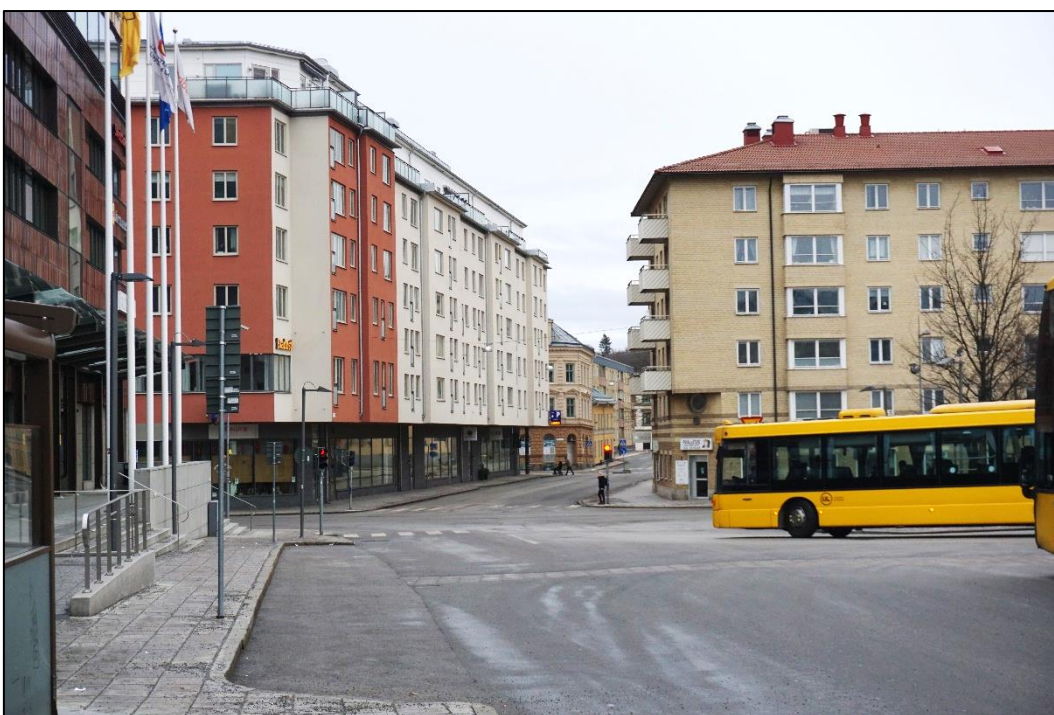
I kvarteret Högne (till vänster i bild) har ett parkeringshus från 1971 ((Grimbild) byggts om och till för bostäder efter ritningar av White. Byggnadens nya utformning stod färdig 2008.
