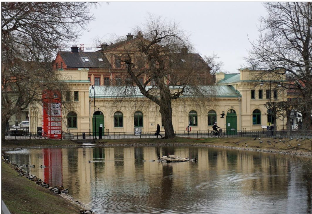
Pumphuset från väster. Byggnaden uppfördes 1874 men fick sitt nuvarande utseende med ljusa putsfasader 1901.
