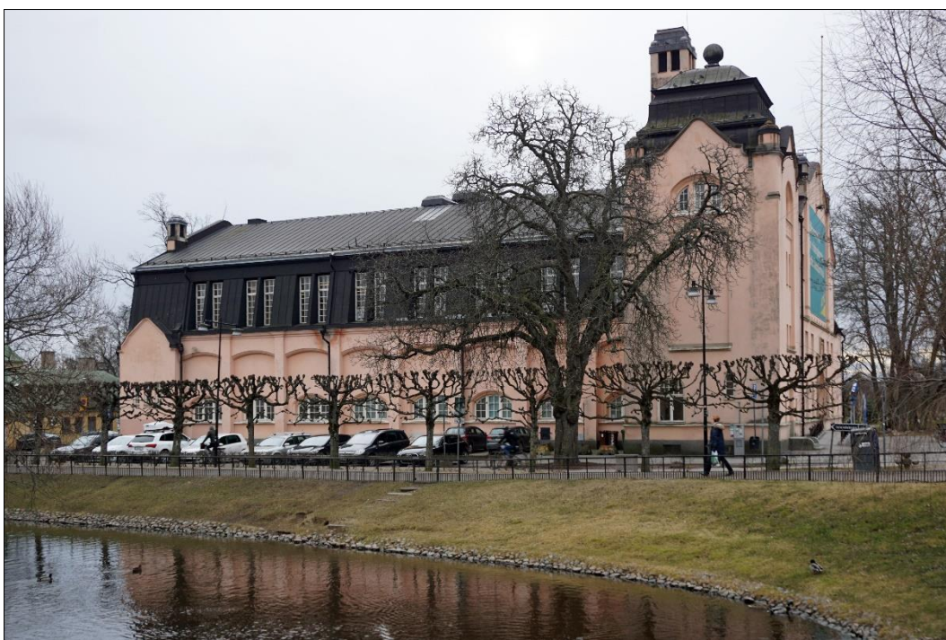
Studenternas gymnastikbyggnad "Svettis" uppfördes 1910 efter ritningar av Ture Stenberg 1903 och 1907. Den är idag byggnadsminne.
