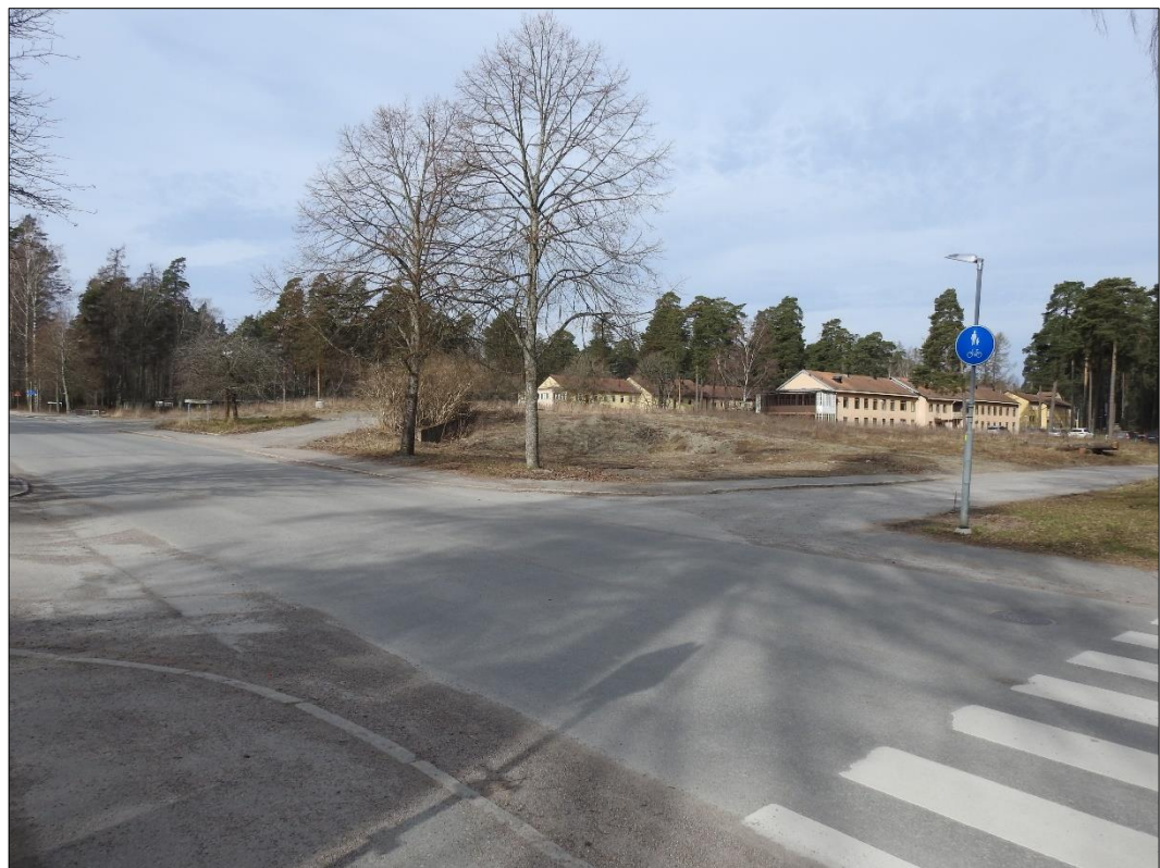
Inom Ulleråkersområdet har den stora centrallassarettet rivits, liksom några ytterligare byggnader.
