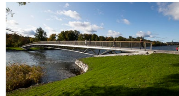
Referensbild: modellerade slänter med dolda landfästen.
