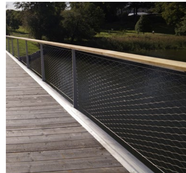
Referensbild: GC-räcke med vajermesh och toppföljare med träbeklädning.
